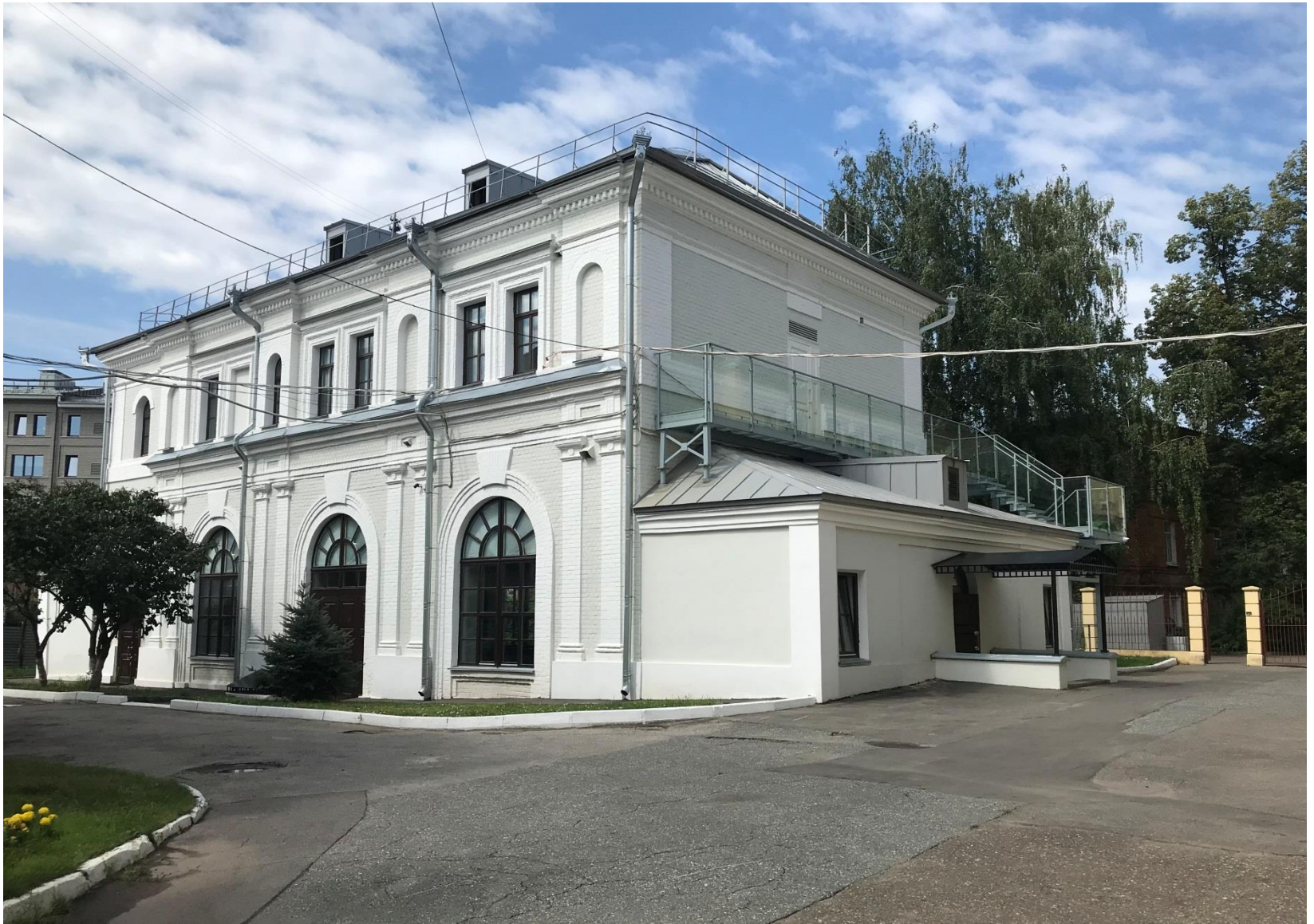
Гимнастический манеж Александровского дворянского института в Нижнем Новгороде, 1894. Приспособление под Школу креативных индустрий. СМУ 77, арх. А. Тарасов, 2022-2023. Фото А.Л. Гельфонд, 2024
